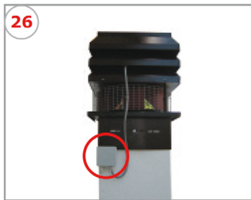
Posición correcta de la caja de derivación.
